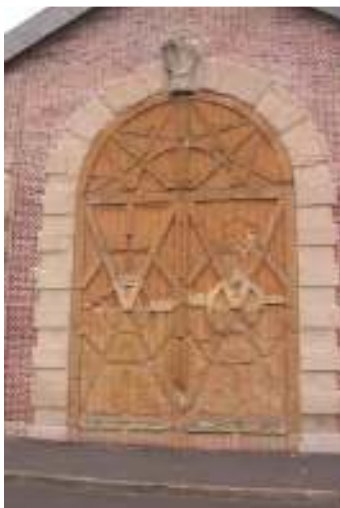
Figure 1. Porte en béton imitant le bois, Ferme du Buisson, Noisiel, (© Emmanuel MAURIN)
