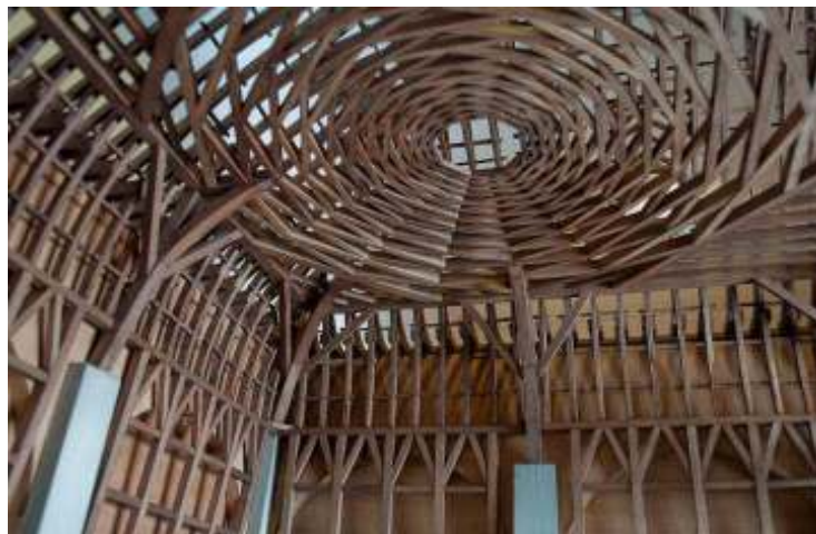
III. 4 - Plancher polygonal appartenant au modèle du comble de Saint-Germain-des-Prés réalisé par Beloni Minard. Ca 1884. Musée des Arts et Métiers Inv. 10979.
