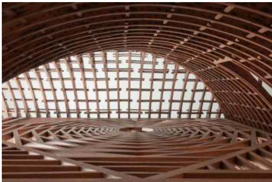
Ill. 1 - Vue intérieure du modèle du comble de Saint-Germain-des-Prés réalisé par Beloni Minard. Ca 1884. Musée des Arts et Métiers, Inv. 10979.
